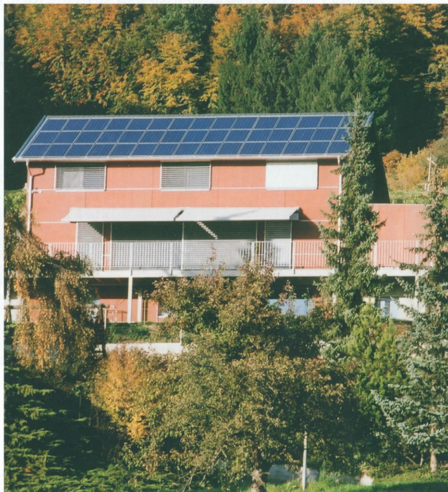
Ein kompaktes Volumen, PV-Zellen auf dem nach Süden orientierten Dach und die thermische Entkoppelung aller aussen liegenden Elemente kennzeichnen das Passivhaus am Rand des Dorfes Hüttwilen. Fotos Architekt
