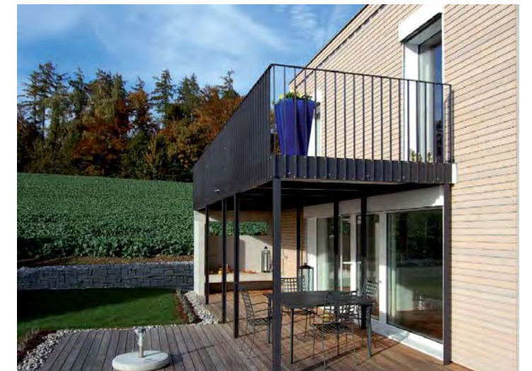
L'association ossature bois, isolation thermique de 40 cm d'épaisseur dans les murs et la toiture, et fenêtres bois/aluminium à triple vitrage a passé le test d'étanchéité Blower door sans difficulté.
