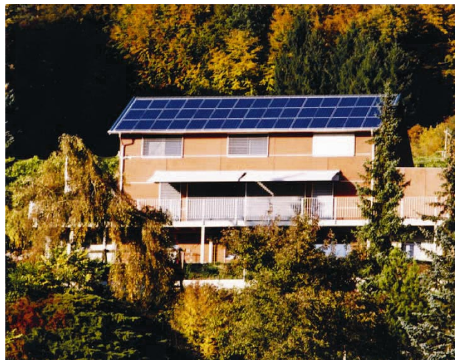
EFH Mischler Lussistrasse in 8535 Hüttwilen, erstes zertifizierte Minergie-P Gebäude des Kt. Thurgaus. Produziert mit der Photovoltaik mehr Energie als es braucht. Blockholzbauweise.
