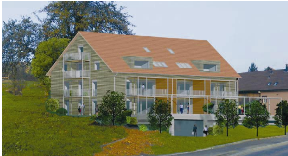
MFH Dietingen in 8524 Buch-Üsslingen, 8 Eigentumswohnungen im Minergie-P Standard, baubewilligt. Massivbauweise mit Holzfassade.
