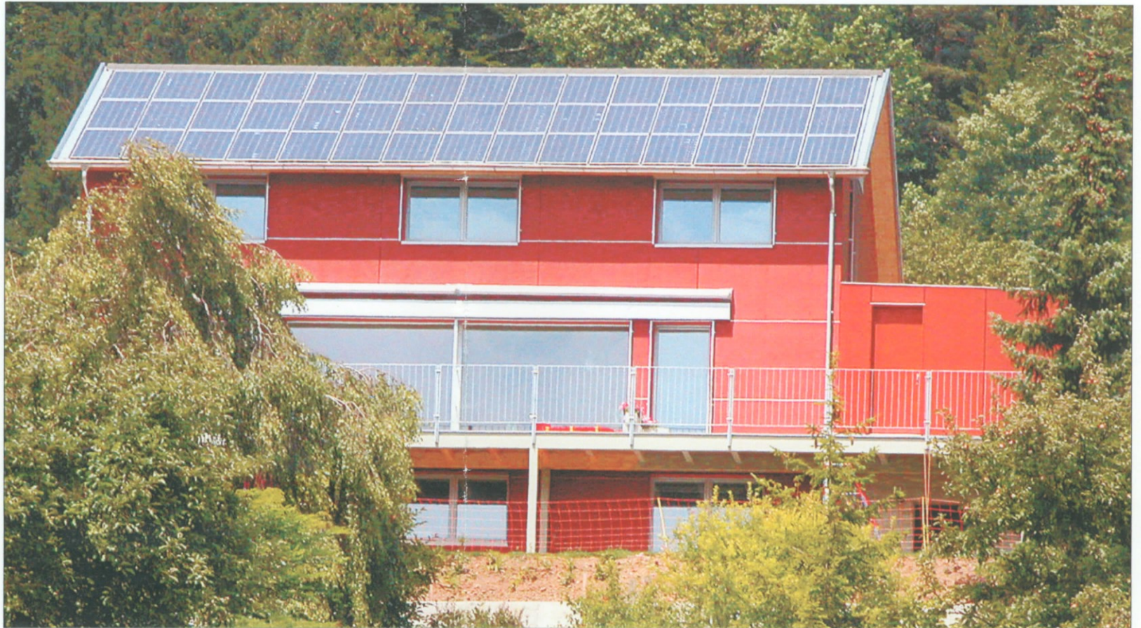
Das Minergie-P-Haus an der Lussistrasse in Hüttwilen. Gut sichtbar ist die Photovoltaikanlage, die durchschnittlich mehr Strom produziert, als das Haus benötigt.
