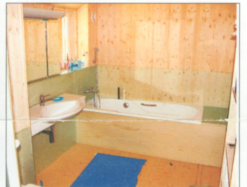
Konsequent: Die Familie Mischler verzichtete sogar auf Keramikplatten in den Nassräumen.
