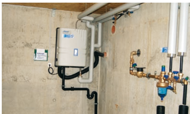
Option Regenwasser Nutzanlage
