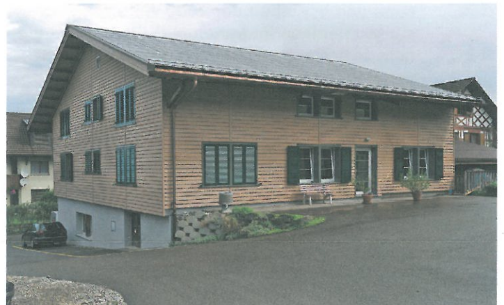
Wie neu: Das Minergie-P-Mehrfamilienhaus in Hüttlingen nach der Gesamtanierung. (Foto Gerber Verlag)
