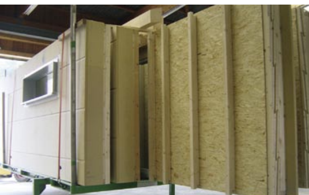
Préfabrication des éléments en bois
