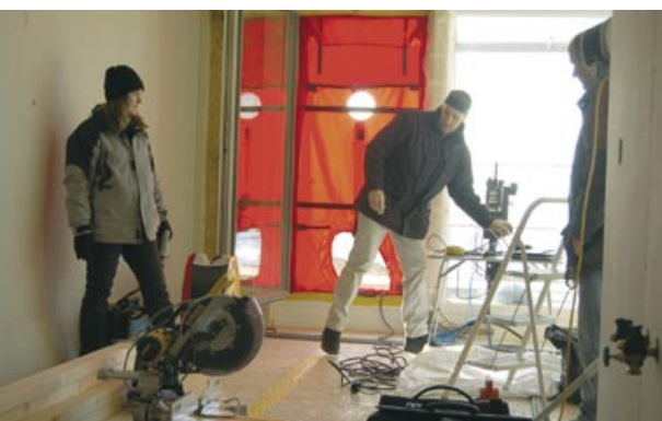
Teste d'étanchéité Blower-Door
