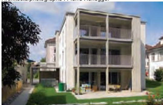
Habitat collectif à CH-Willisau bilan énergétique positif et certifié Minergie-P® Architecte/photographe : Pierre Honegger
